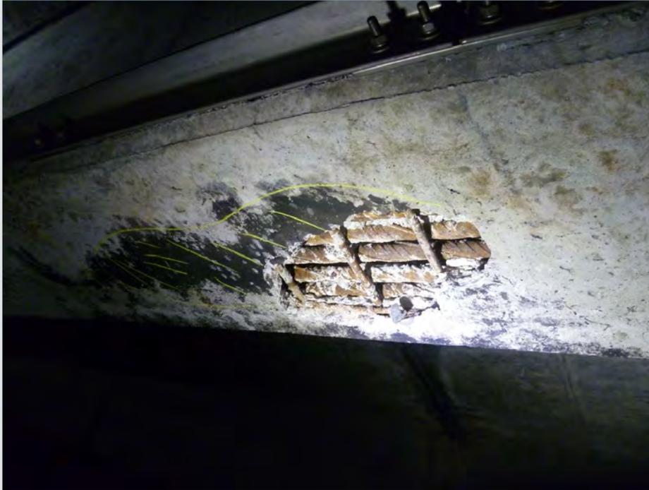
Abb.: Im Zuge der Voruntersuchung freigelegte Bewehrung der Kragarme zur Festlegung möglicher Instandsetzungsmaßnahme
